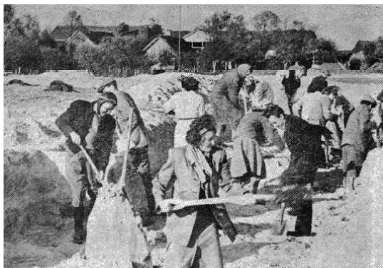
Czyn społeczny przy budowie kanału [1].
