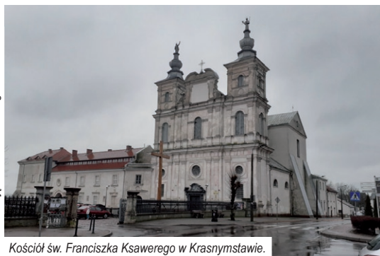
Kościół św. Franciszka Ksawerego w Krasnymstawie.
