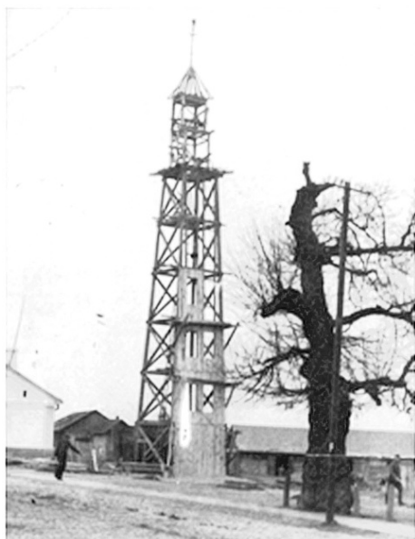
Wieża - wspinaczka Zawodowej Straży Pożarnej w 1945 roku.
