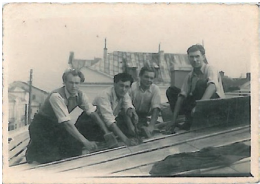
Krycie dachu na Domu Nauczyciela przy ul. Głównej (obecnie Matysiaka) w Krasnymstawie, rok 1951. Od lewej: Witold Ilczak, Ciesiek Gryć, Idek Ciećko, Wacek Podolski (fot. archiwum prywatne Witolda Ilczaka).
