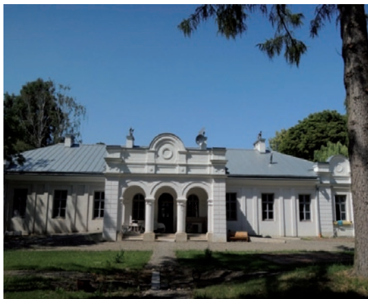
Dwór w Udryczach Koniec. Widok na elewację frontową z centralnie usytuowanym portykiem. Źródło: http://www.udrycze.pl/common/podglad2.php?id_zdjecia=634&l=pl [dostęp: 13.02.2019].
