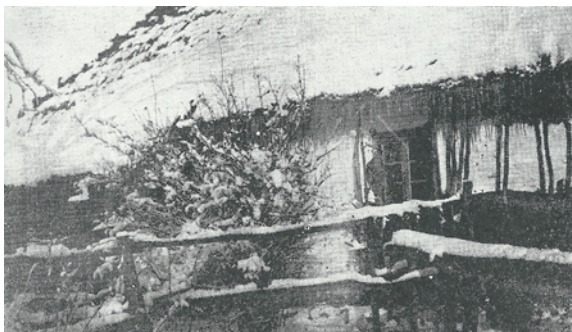
Dom w Olesinie, w którym prowadzono nasłuch radiowy i przygotowywano brudnopisy, wykonywano tytuły i winietki, gromadzono także zaopatrzenie. Tutaj J.N. Kłowski przygotowywał teksty m.in. do „Zielonej Kadry”, „Wyzwolenia”, „Kukułki” (źródło: Z.J. Hirsza, „Lubelska prasa konspiracyjna 1939-1944”, Lublin 1968, wkt. po s. 368).
