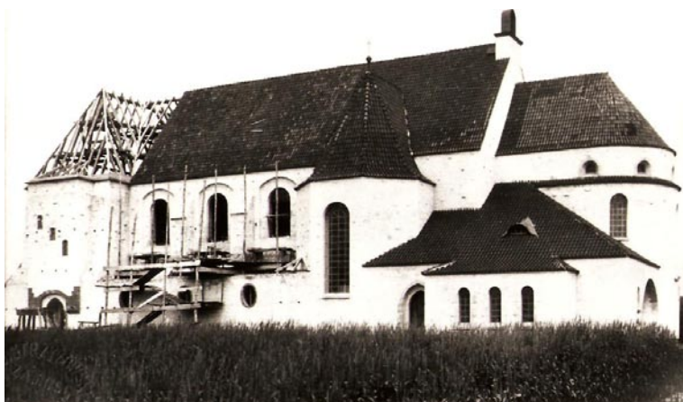
Budowa kościoła w Orłowie Murowanym - 1923-29.
