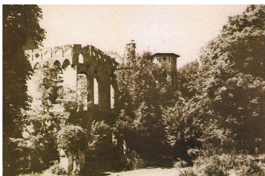
Pałac w Żdżannem po spaleniu
