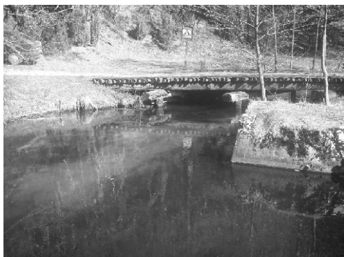
Przez taki mostek prowadziła droga na kwatery w Budach.
